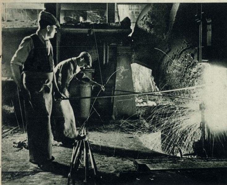
O aço em fusão, com o seu fogo de artifício de faíscas, é lançado nos moldes
