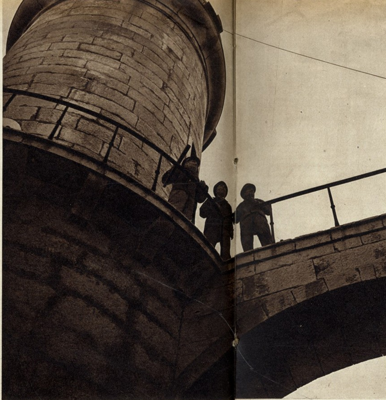
O Bugio foi antigamente uma poderosa fortaleza que defendia o acesso ao Tejo. A sua torre, feita de duro granito, que tem resistido aos anos e às tempestades
