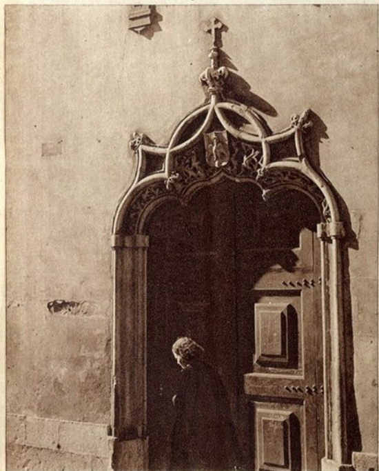
Um lindo pórtico na rua dos Remédios de arco trilobado em que o trabalho de pedra parece filigrana
