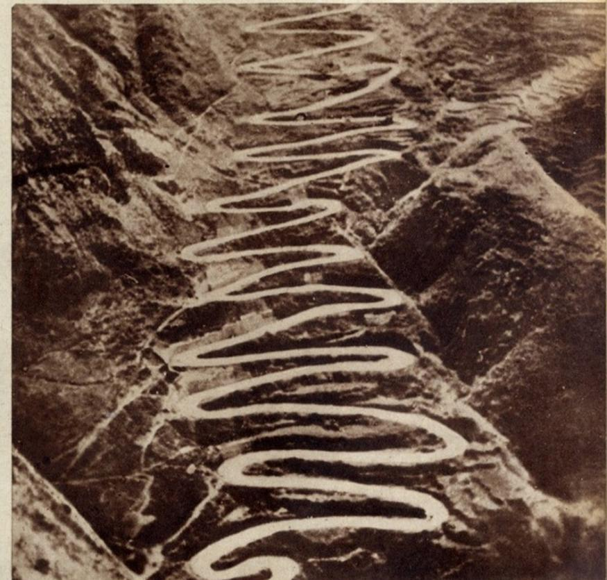
A famosa estrada da Birmania com o seu traçado sinusoidal, assim feito para dificultar os ataques da aviação. Milhares de cantoneiros foram ali instalados podendo qualquer buraco provocado por uma bomba ser reparado em poucos minutos
