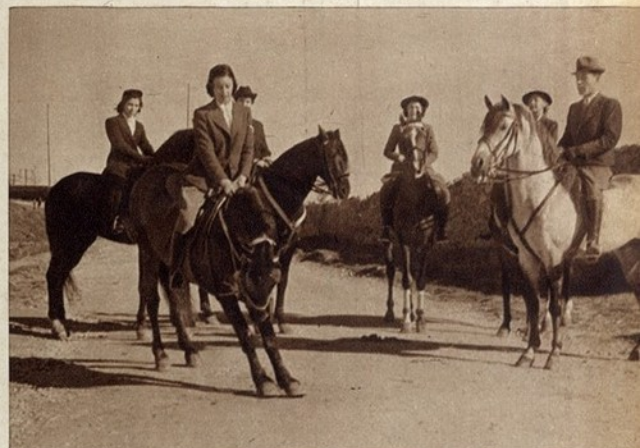
O equitador Diogo, da escola de António Correia, acompanhou as suas discípulas no exercício no campo. Uma delas faz executar primorosamente ao cavalo a «reverence»
