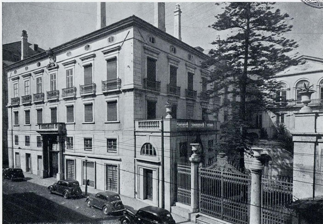
Fachadas Sul do Palácio Palmela, dos Sousa Calharizes, no largo do Calhariz e que foi adquirido pela Caixa Geral de Depósitos (pag. 45)
