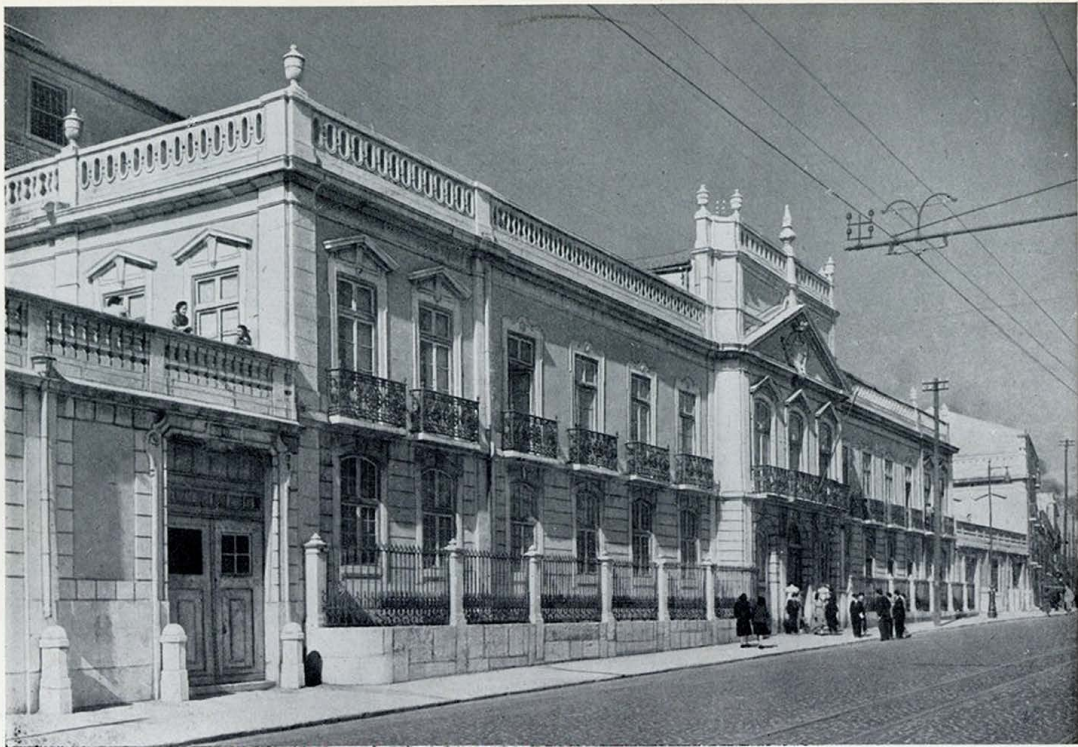
Fachada do antigo Palácio Ribeira, sobre a Rua da Junqueira, distinguindo-se o decorativo corpo central (pág. 50)
