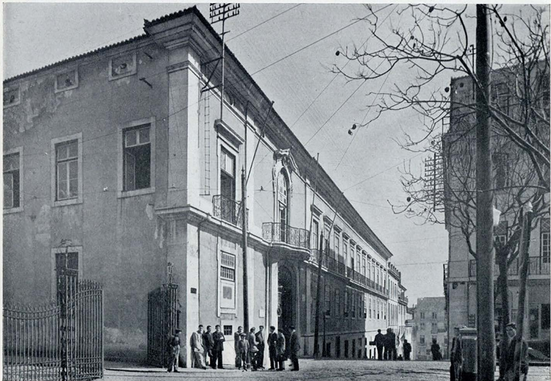
Fachada do antigo Palácio Valadares, sobre o Largo do Carmo e Calçada do Sacramento. É hoje a Escola Veiga Beirão (pág. 54)
