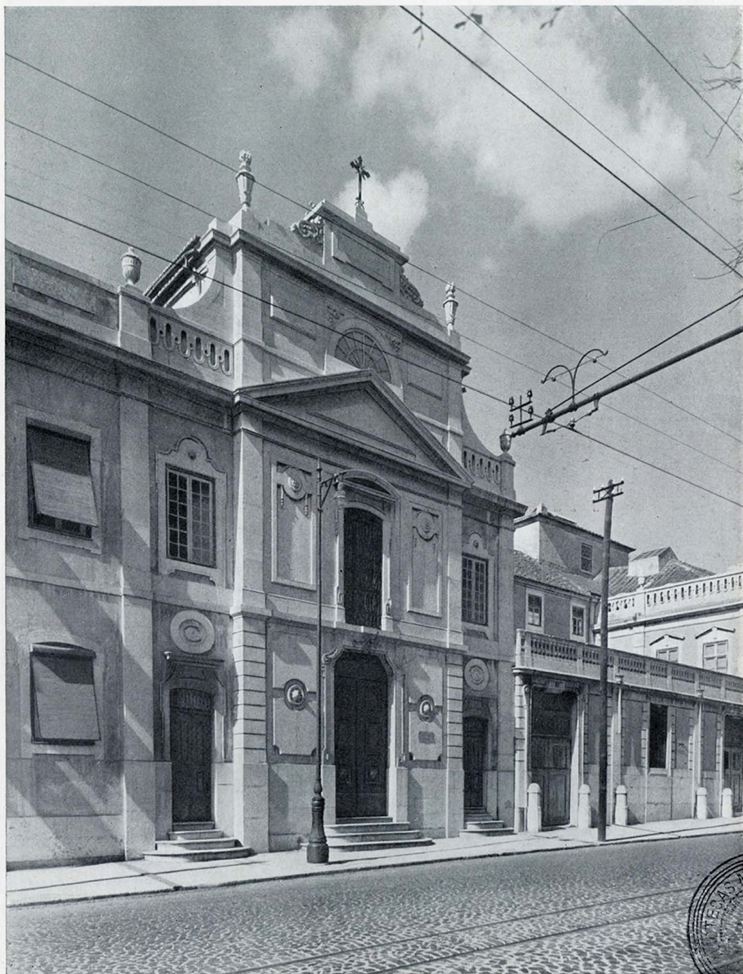
Frontaria da capela do Palácio Ribeira, na Junqueira, construção do século XIX (pág. 50)
