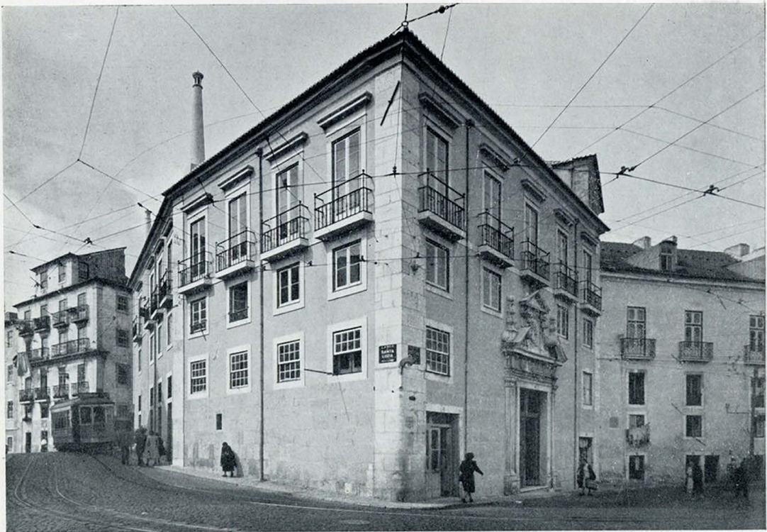
Fachadas sobre os Largos das Portas do Sol e de Santa Luzia, distinguindo-se à direita do portal nobre a torre da Cerca Moura (pág. 19)
