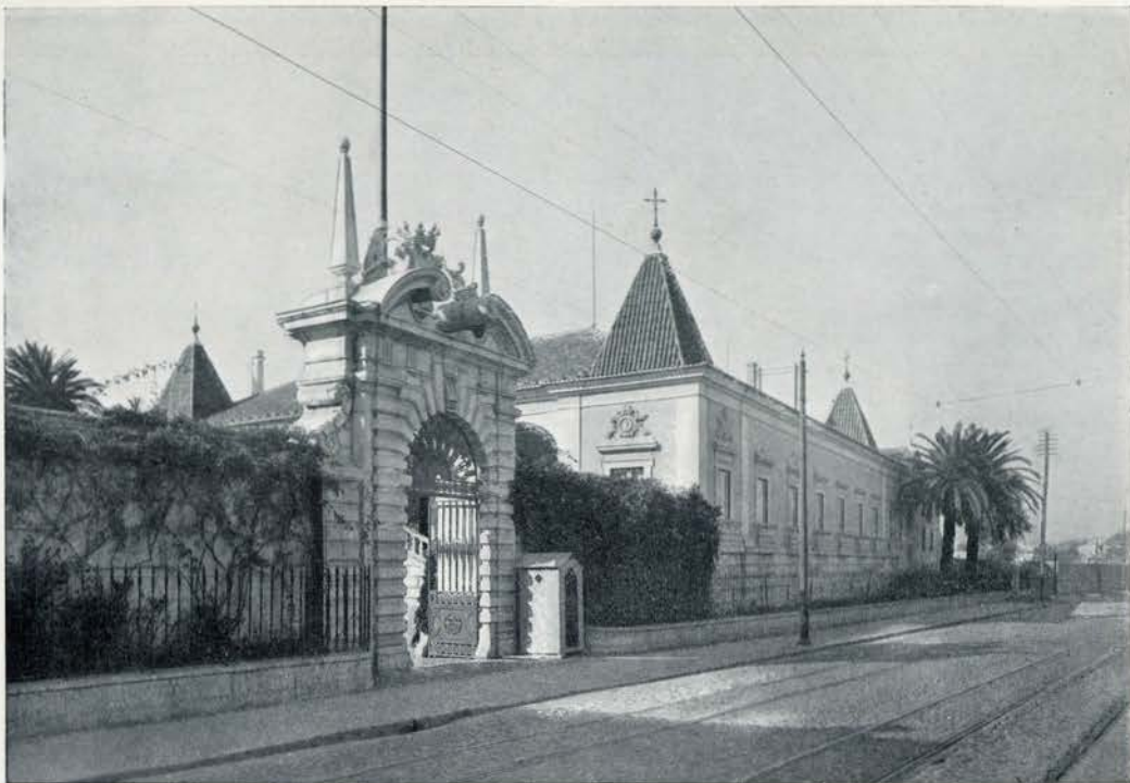
Fachada sobre a Estrada de Benfca-Palhavã, com o portal nobre de acesso ao pátio (pág. 12)
