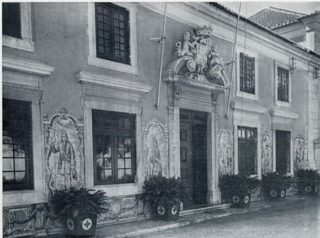
Fachada Norte do palácio, depois do restauro, com o portal primitivo armoriado (pág. 50)
