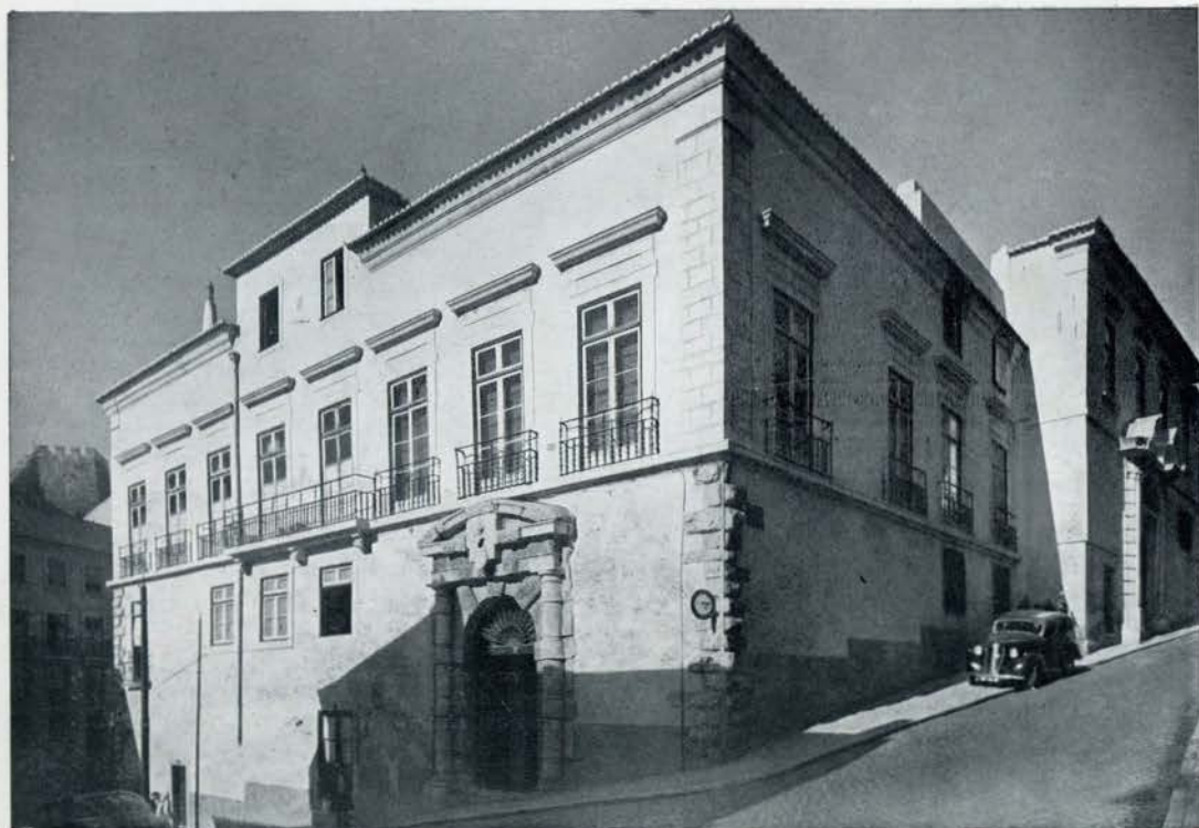
Fachada principal, com o portal seiscentista, e parte da fachada da Calçada da Graça (pág. 56)
