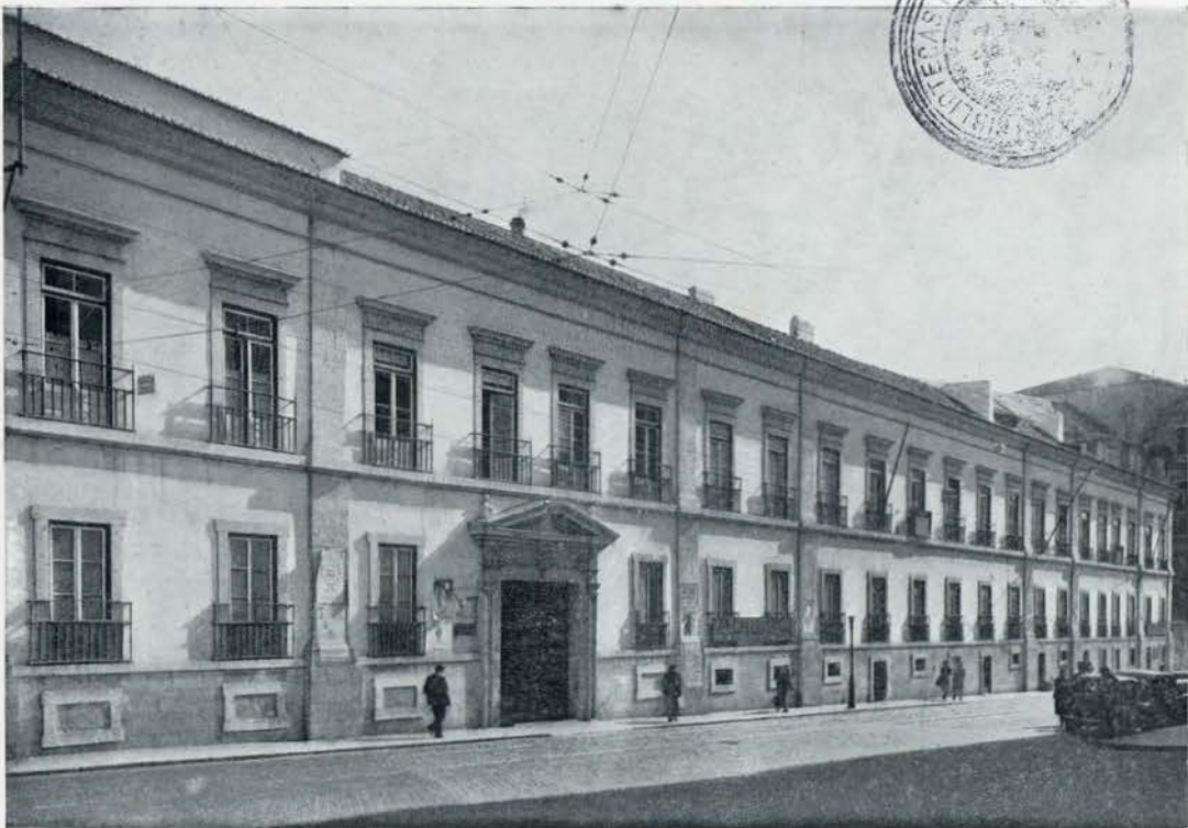
Fachada do antigo palácio dos Condes de Redondo, sobre a Rua de Santa Marta (pág. 60)
