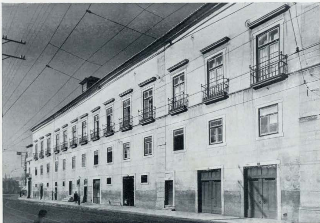
Fachada na Rue de Xabregas, vendo-se à esquerda o portão que leva ao pátio nobre posterior (pág. 46)
