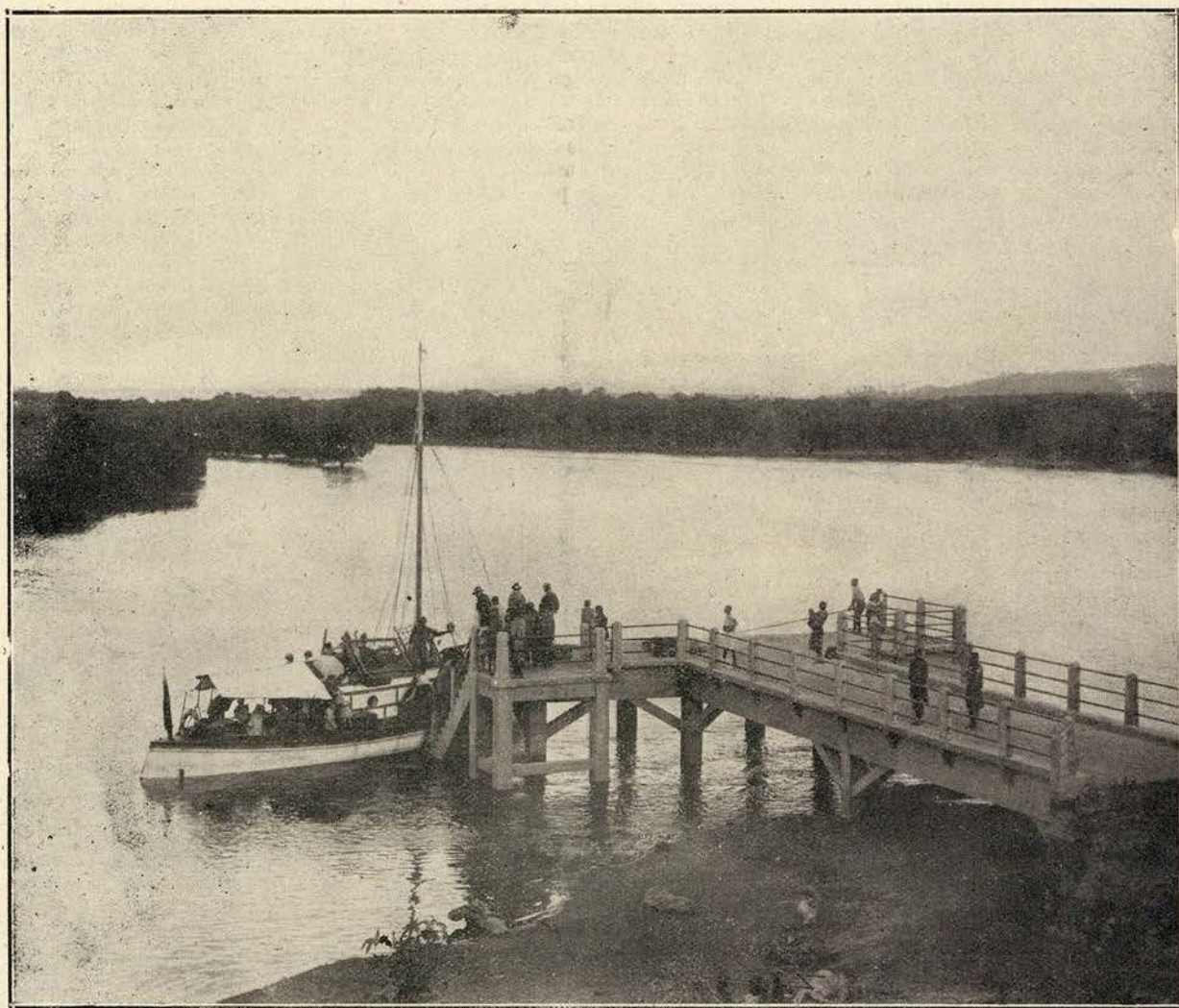
Ponte-cais de Morruntene (Districto de Inhambane) Atracção do gazolina das carrúias regulares. — INHAMMBANE — MORRUNTENE
