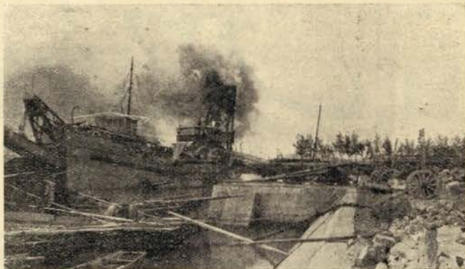
Draga «Rotterdam» no Patane, impelindo productos de dragagem para o aterro da Areia Preta
