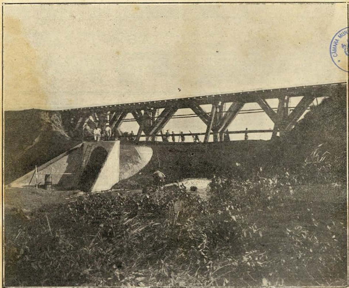
MOÇAMBIQUE—Substituição da ponte provisória de Chongolá na linha ferrea de Inhambane por um aqueducto em cimento armado (trabalho executado em 1915 sem a interrupção do trafego)
