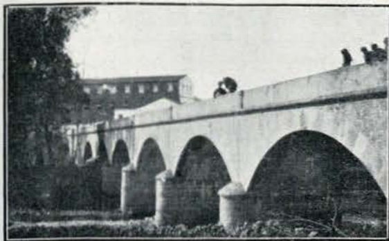
Ponte sobre o rio Nabão—Thomar—por Torres Pinheiro
