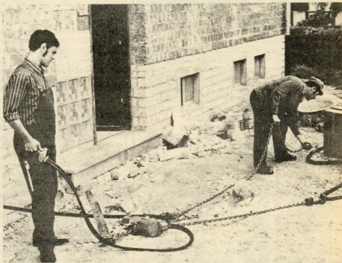
É na construção civil que se emprega uma enorme parte dos portugueses emigrados.
