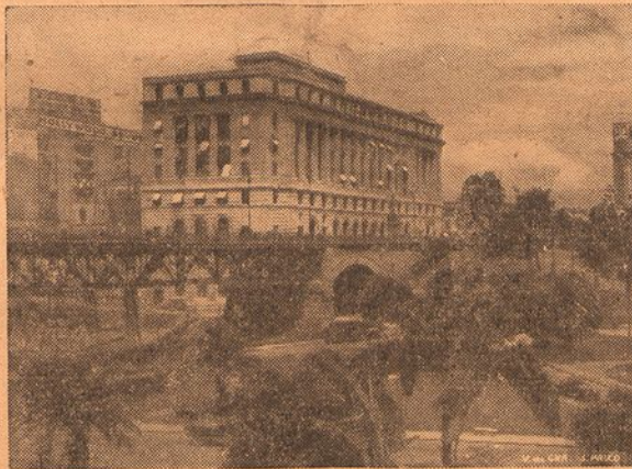
Um aspecto do Viaduto do Chá
