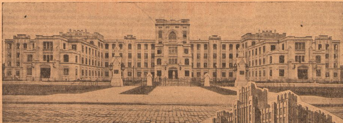
O novo edificio do Instituto Biológico—Faculdade de Medicina
