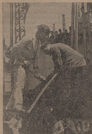
Os operarios procedendo à cravação do primeiro rebite do novo barco
