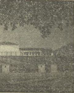
O excelente edificio da escola agrícola para formação profissional de trabalhadores do campo, construída em Benavilla (Avis) pela Fundação Abreu Calado. O projecto foi elaborado pelo arquitecto Reed Teixeira
