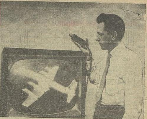
A mais pequena camera de Televisão do Mundo (125 milímetros, por 50 milímetros e 43 milímetros) que as fábricas Lock Heed utilizam para projecção das modelas de aviões em construção. Aqui vemos o modelo do novo avião a jacto «Victor»
