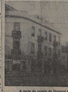
A parte da capela do Hospital Curry Cabral que vai ser demolida
