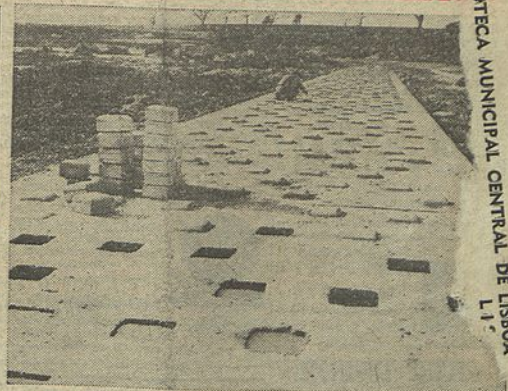
Em geral, procura-se que o pavimento das estradas seja tão liso quanto possível. Mas no trecho que se vê aqui em construção foi exactamente o contrário que se teve em vista. Com as solências destinadas a submeter a enorme tráfego os veículos que sobre ela rolem, esta reprodução artificial de um mau caminho faz parte de um novo centro de ensaios da Vauxhall, no Grã-Bretanha
