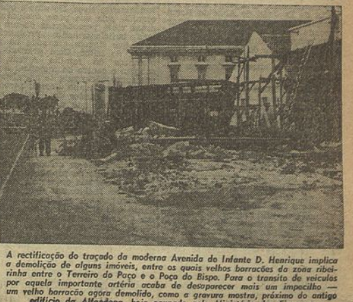
A rectificação do traçado da moderna Avenida do Infante D. Henrique implica a demolição de alguns imóveis, entre os quais velhos barracões da zona ribeirinha entre o Terreiro do Paço e o Poço do Bispo. Para o transito de veículos por aquela importante arteria acaba de desapparecer mais um impedição — um velho barracão agora demolido, como a gravura mostra, próximo do antigo edificio da Alfândega, hoje ocupado pelo Ministério das Finanças
