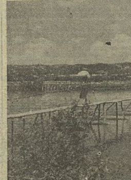
O porto do Vau da Granja, no Mondego, onde vai ser construída uma ponte
