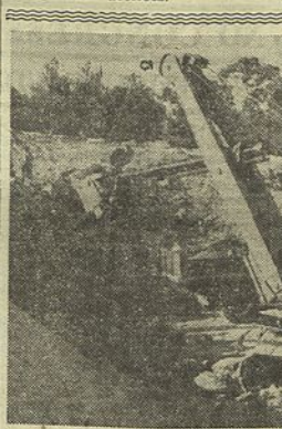
A escavadora «Demag», a ser utilizada nos terrenos do hotel que está a ser construído na rua Castilho
