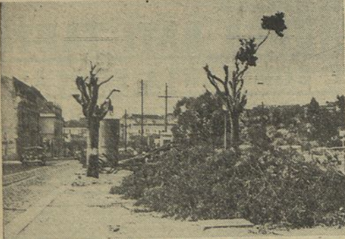
No Avenida Fontes Pereira de Melo, começaram a ser cortadas as frondosas árvores das placas centrais, a fim de se proceder, em seguida, ao desvio do colector de esgotos...
