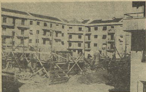
Aspecto da construção do prédio sobre o terreno do logradouro da Pracetá do Estado da Índia, em Moscavide
