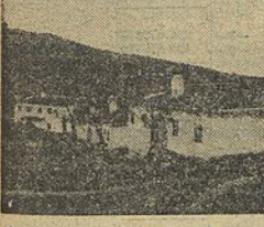
As primeiras três moradias do bairro para pobres em Portalegre
