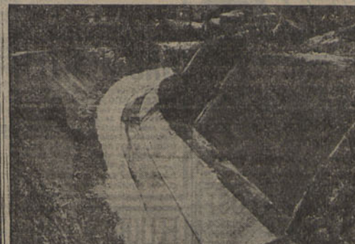
Tem sido preocupação do Governo a extinção dos deficits de subsistências em Goa, onde a grande maioria da população se alimenta de arroz. Para acilivar a sua produção, estão em execução dois canais de irrigação, com barragens, que foram buscar os seus nomes aos rios que os alimentam — a Gandaper e o Parodá — cujo custo é, respectivamente, de 7.750 e de 11.500 contos. As gravuras mostram dois aspectos do canal de Parodá
