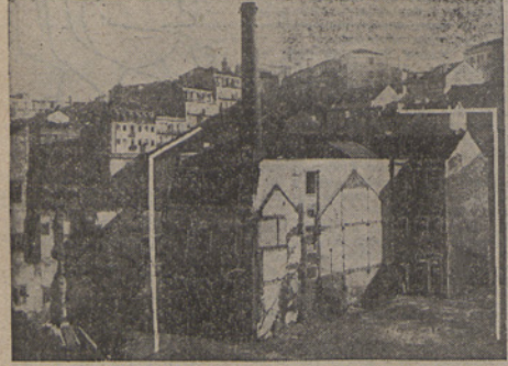
Aspecto do «baixo da Silva e Albuquerque», com indicação dos prédios que vão ser demolidos
