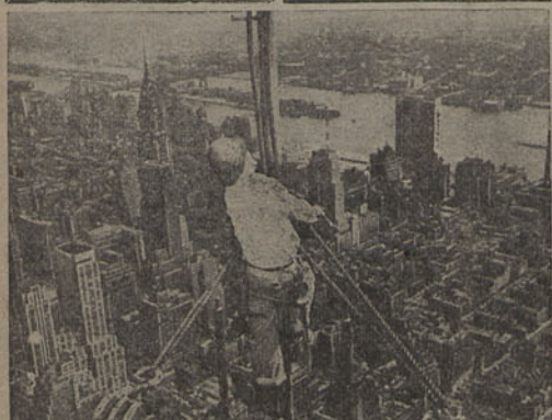
No cimo do «Empire State Building», que já era o «arranha-céus» mais alto do Mundo com 375 metros, está a ser construída uma antena emissora de televisão com 67 metros. O trabalho é ariscado mas como se vê, proporciona aos técnicos um espectáculo deslumbrante sobre a grande metrópole americana. À esquerda vê-se a agulha que remata o «Chrysler Building», e no fundo, junto ao rio, o bloco rectangular do novo edificio do Secretariado da «ONU»
