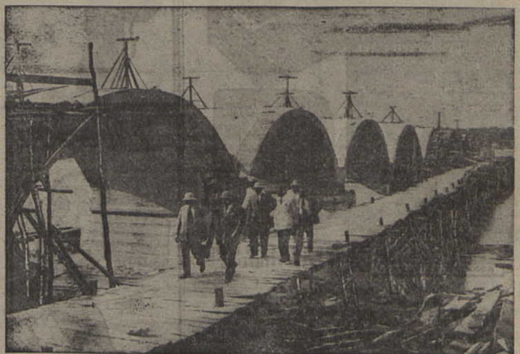
Um aspecto da maior ponte de escaidas, de Angola, em construção sobre o rio Quanza, em Porto Condo. Na gravura, vê-se o governador geral de Angola, capitão Silva Carvalho, que recentemente ali foi visitar os trabalhos de construção. (Foto «Lusitania»)
