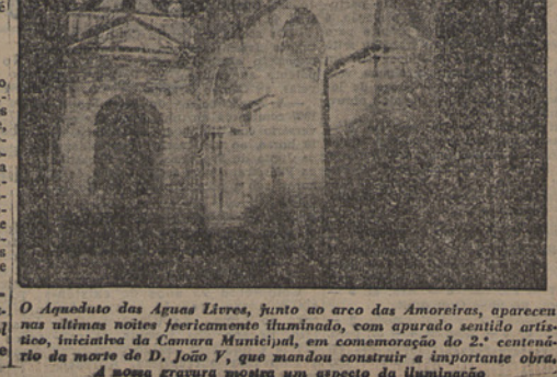
O Aqueducto das Aguas Livres, junto ao arco das Amoreiras, apareceu nas últimas noites feericamente iluminado, com aparato sentido artístico, iniciativa da Câmara Municipal, em comemoração do 2.º centenário da morte de D. João V, que mandou construir a importante obra.
