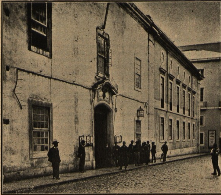
FACHADA PRINCIPAL DO GOVERNO CIVIL
