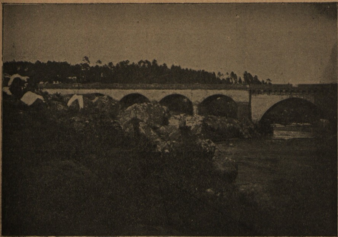
S. PEDRO DO SUL — Ponte sobre o Vouga
