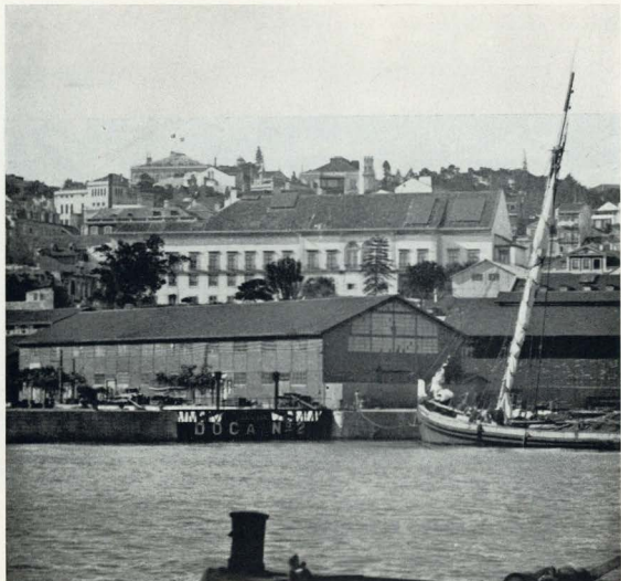
Fig. 4 — PALACIO DAS JANELAS VERDES (fachada sul). Aspecto anterior às obras iniciadas em 1942.
