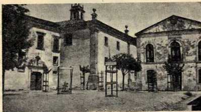
TENTÚGAL. — FACHADA LATERAL DO CONVENTO
