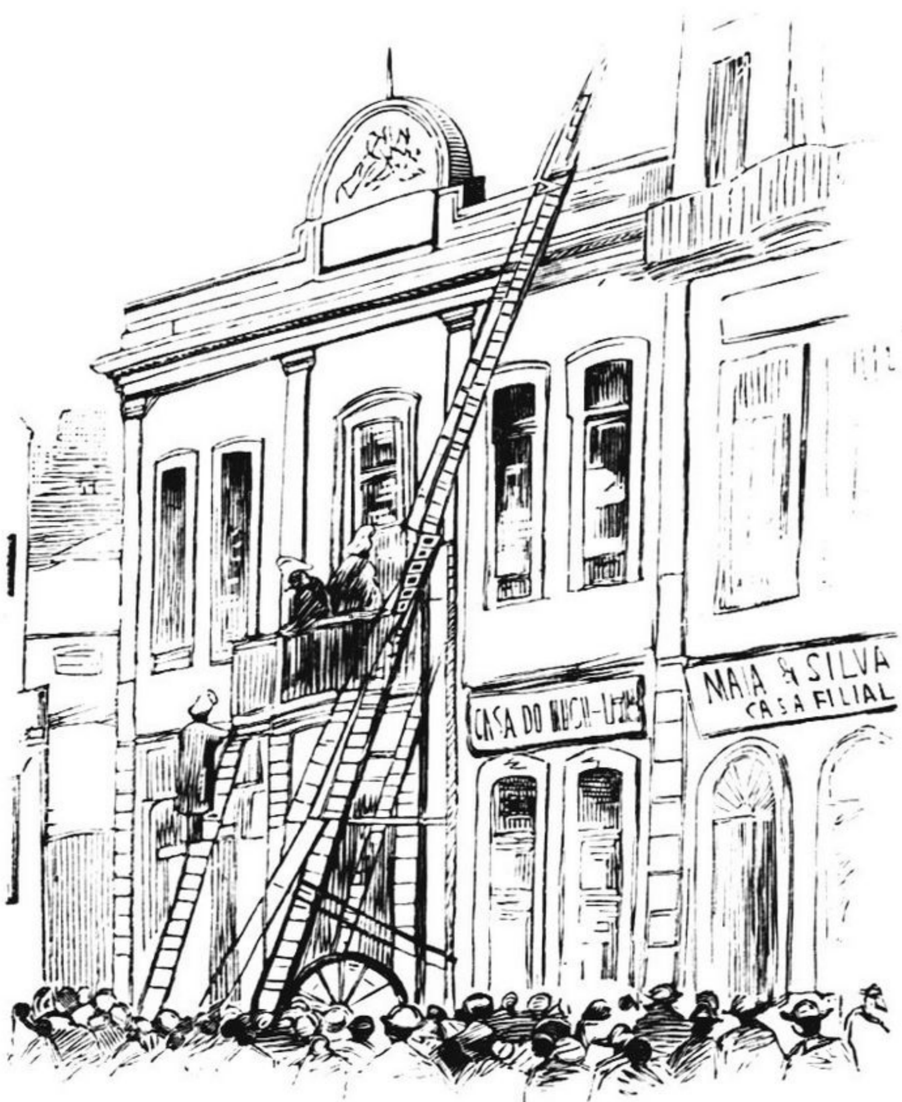
(Fachada da rua Sã de Bandeira durante o incendio)
