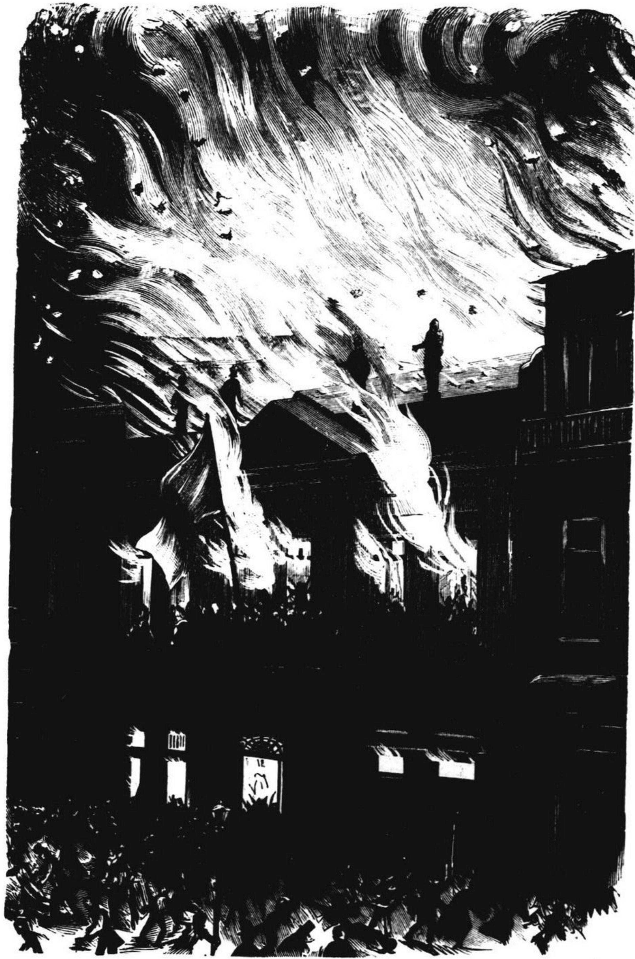
(Fachada da rua de Santo Antonio durante o incendio)
