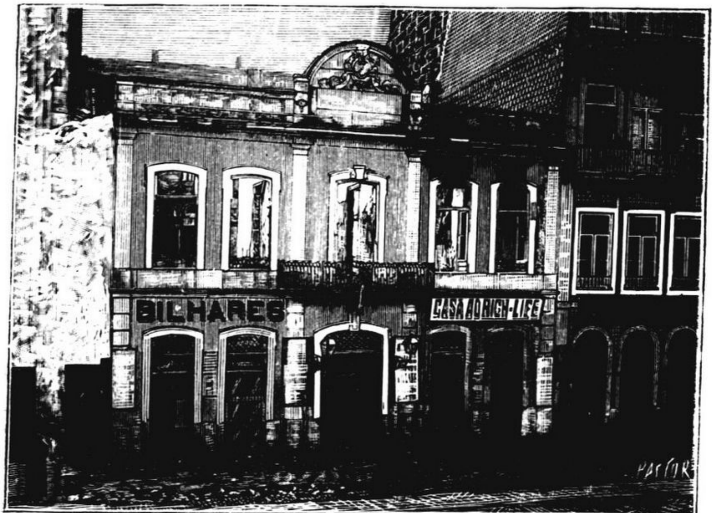
(Ruinas da fachada da rua de Sã da Bandeira)
