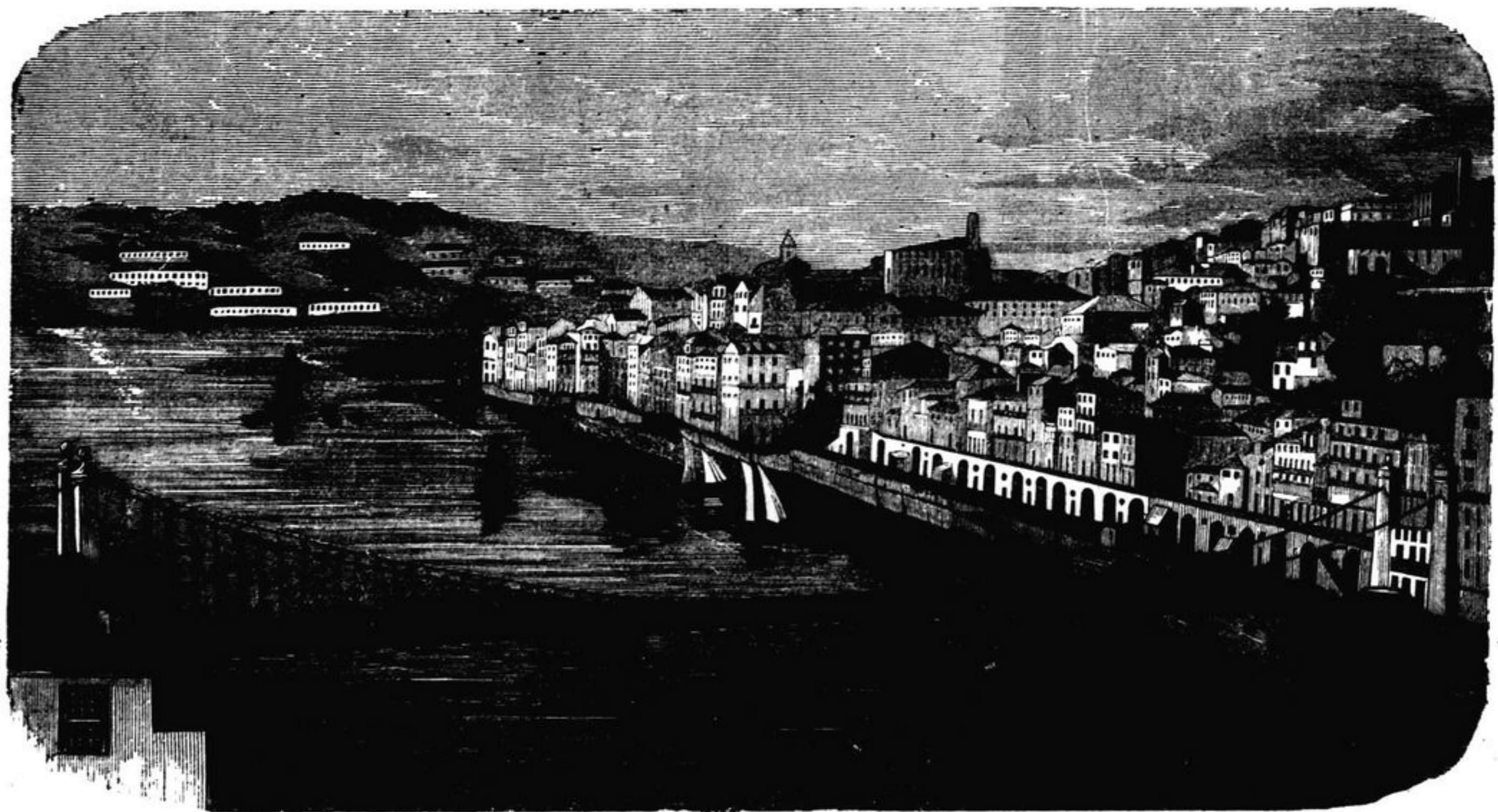
PONTE PENSIL DO DOURO
