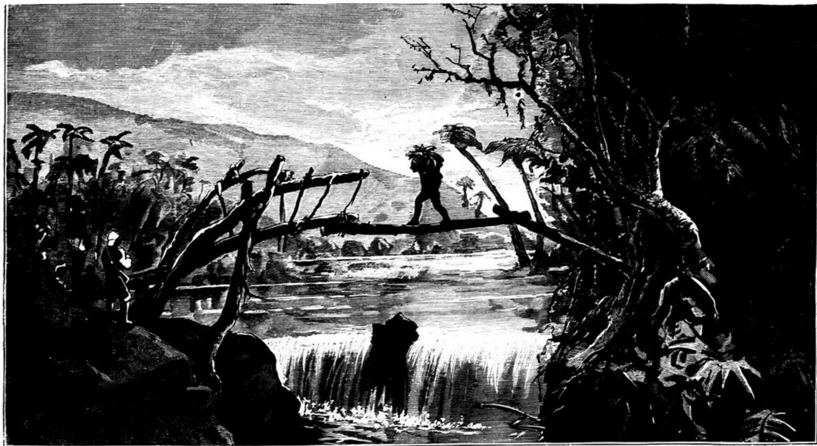
PONTE SOBRE UMA CACHOEIRA NO RIO AMAZONAS
