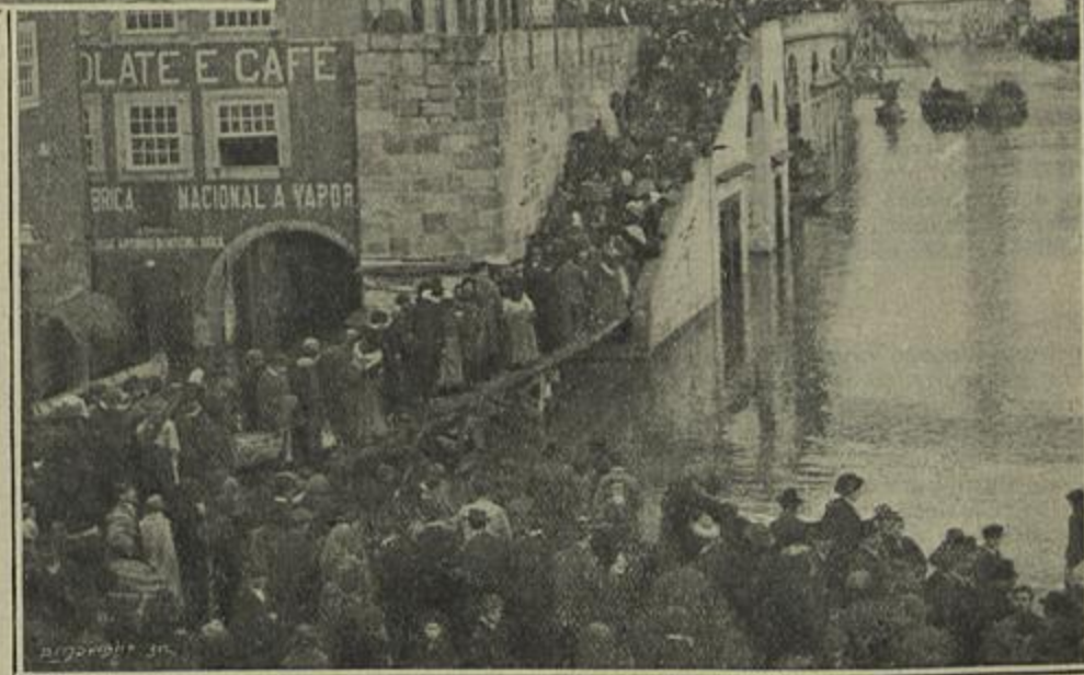
PORTO — EM MASSARELLOS REFORÇANDO AS AMARRAÇÕES DOS NAVIOS QUE VÃO À PESCA DO BACALHAU — A INUNDAÇÃO EM MIRAGAIA — INUNDAÇÃO DO CAES DA RIBEIRA, PASSAGEM IMPROVISADA DA RUA DE S. JOÃO PARA CIMA DO MURO.
