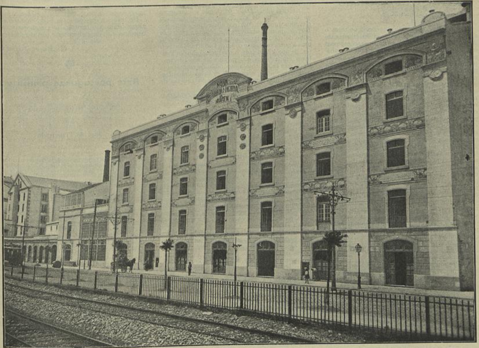
EDIFÍCIO DA FABRICA DE BOLACHAS E MASSAS ALIMENTÍCIAS DA NOVA COMPANHIA NACIONAL DE MOAGEM, INAUGURADO EM 20 DE JUNHO DE 1910
