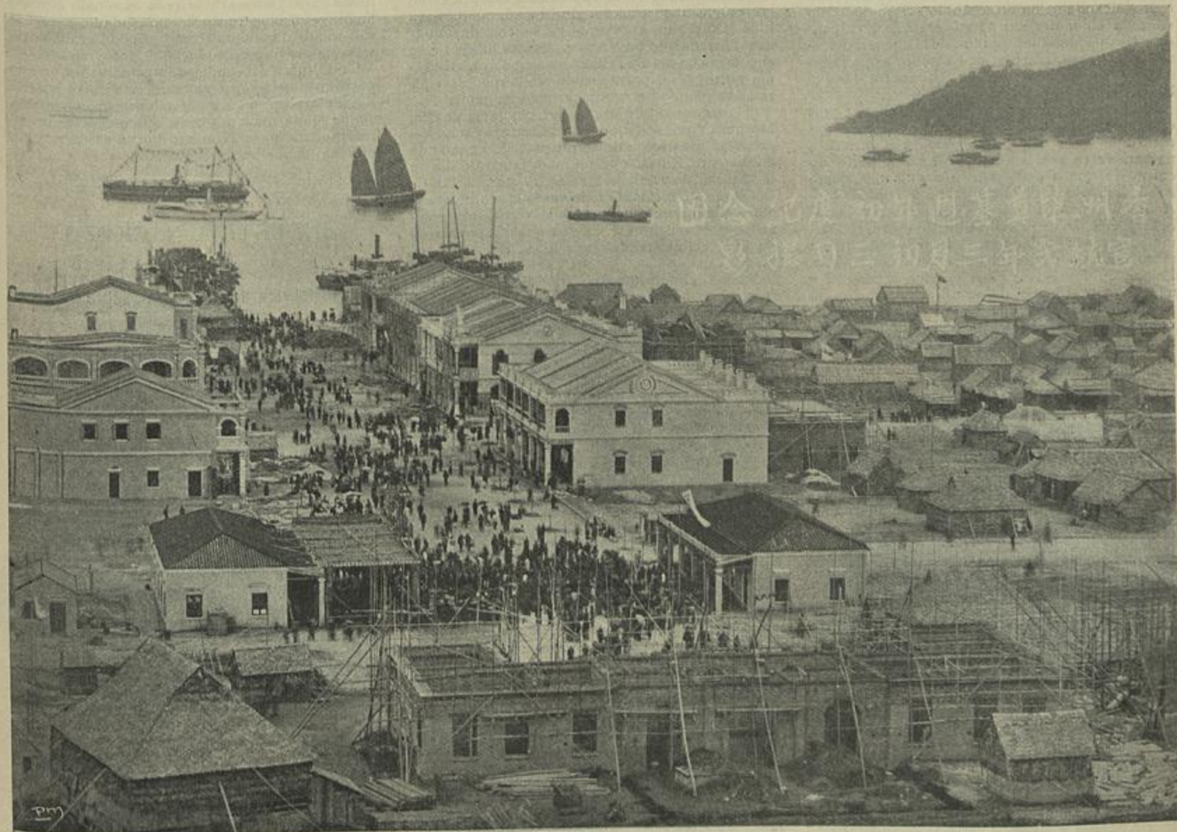
A NOVA CIDADE DE HONG-CHAN, EM CONSTRUÇÃO PELOS CHINEZES, A 7 MILHAS AO NORTE DE MACAU, PARA SUPLANTAREM ESTA CIDADE PORTUGUESA (Fotografia enviada pelo sr. Joaquim Antonio Ferraz à «Mala da Europa»)
