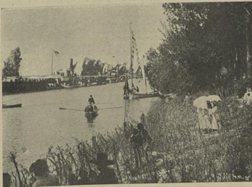
CHEGADA DO VAPOR «D. AUGUSTO» AO CANAL DA AZAMBUJA
