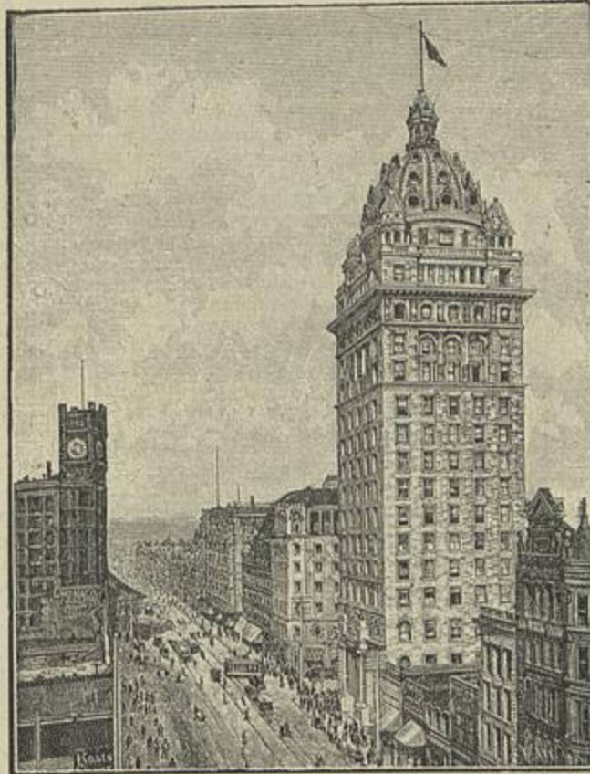
HOTEL RECLAME DE MARKETSTRASSE DESTRUIDO PELO TERREMOTO
