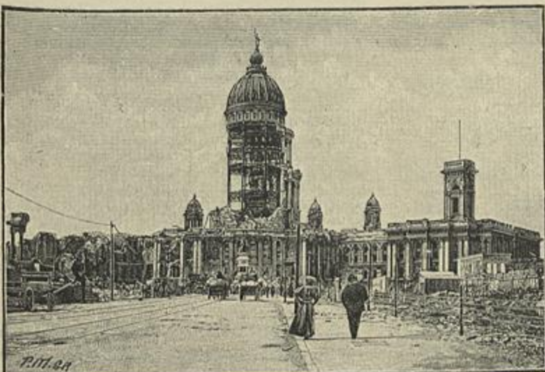
EDIFICIO DA MUNICIPALIDADE DE S. FRANCISCO DEPOIS DO TERREMOTO
