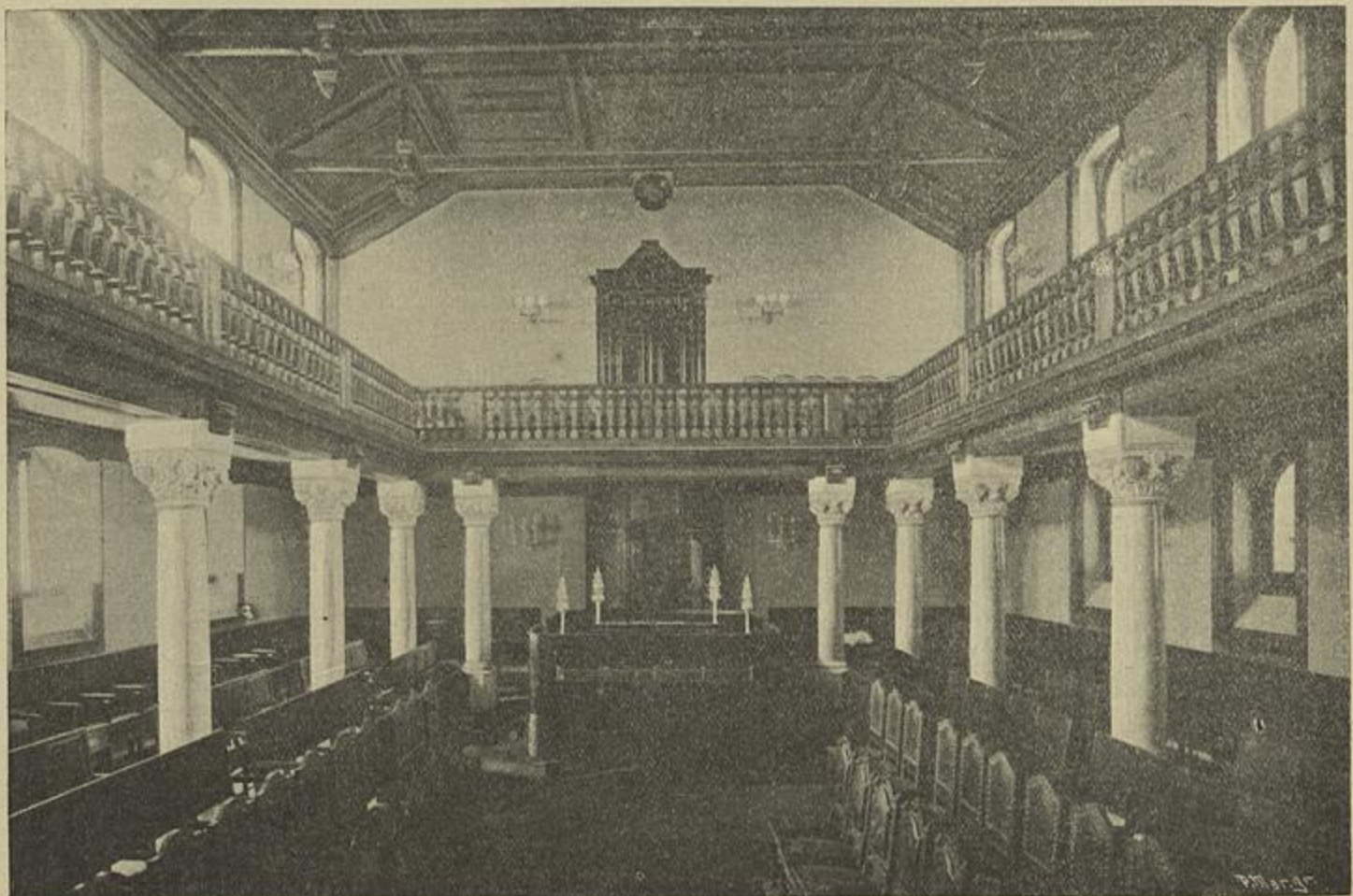
VISTA INTERIOR DA SYNAGOGA — A «TEBA»
