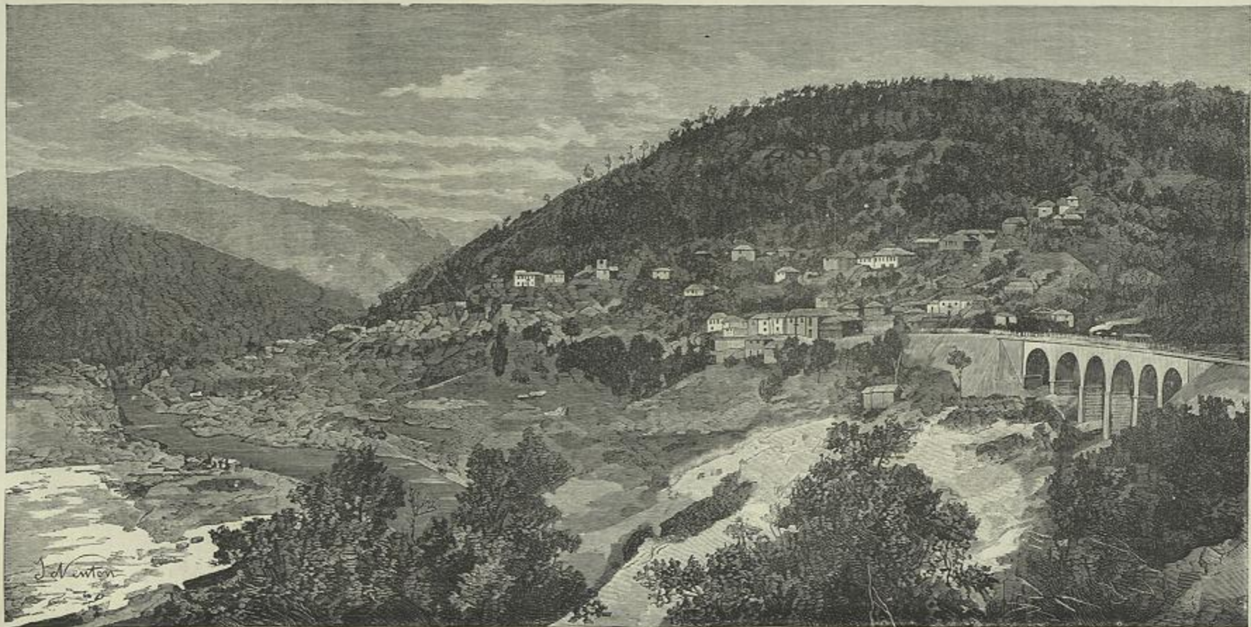
VIADUCTO DO LARANJAL, NO CAMINHO DE FERRO DO DOURO
