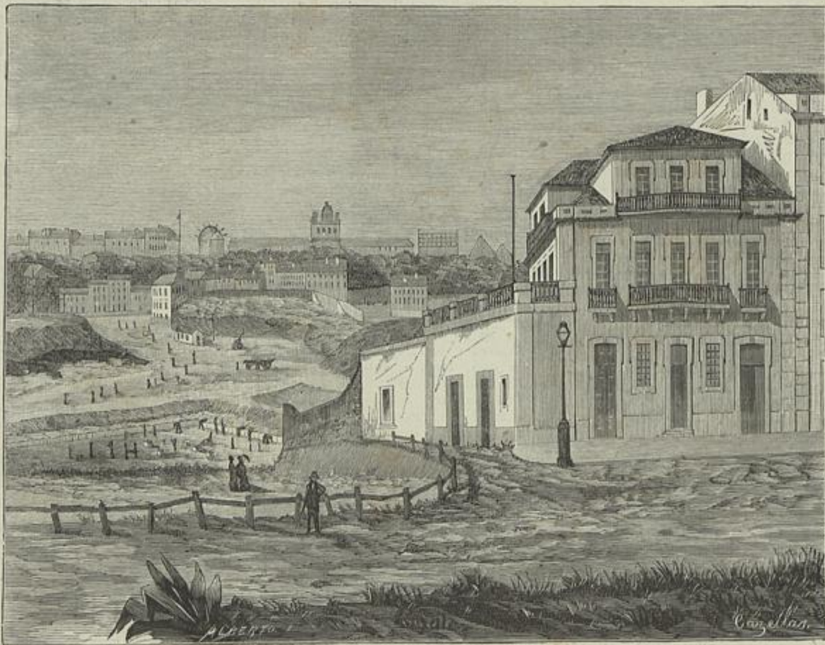
CASA ONDE FALLECEU O MARQUEZ DE SÁ DA BANDEIRA, DEMOLIDA PARA A ABERTURA DA AVENIDA DA LIBERDADE (Desenho do natural por Cazellas)
