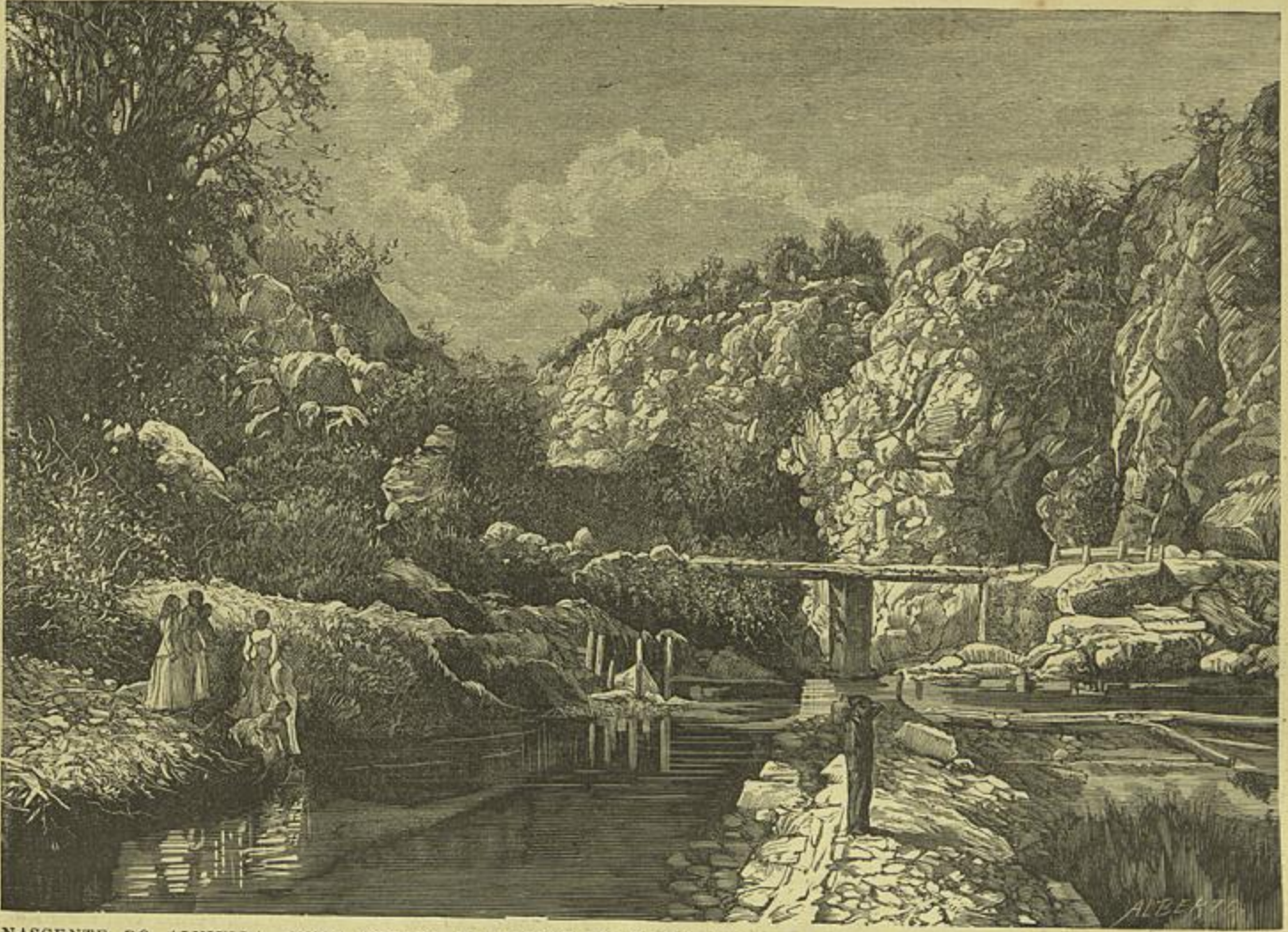
NASCENTE DO ALVIELLA, VISTA TIRADA DO RECEPTACULO DAS AGUAS DA COMPANHIA (Segundo uma photographia de Camacho)
