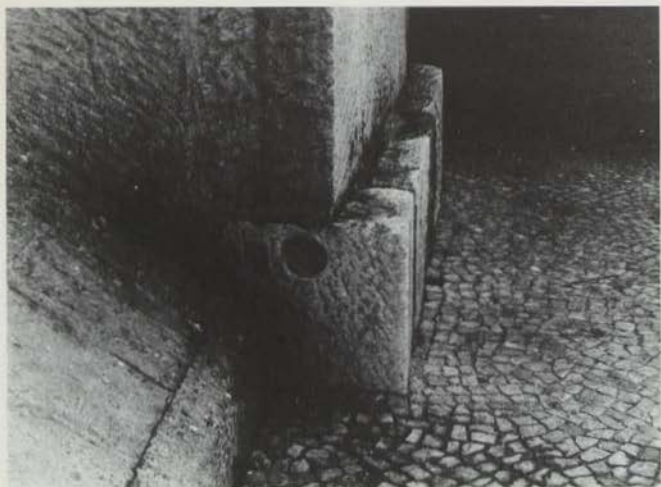
2) Silhar inserto na base saliente e visível das faces Sul e Este do segundo contraforte da torre Sul da Sé
