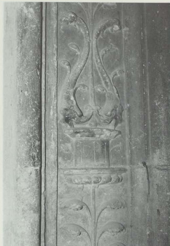
Portal — ombreiras: detalhe
