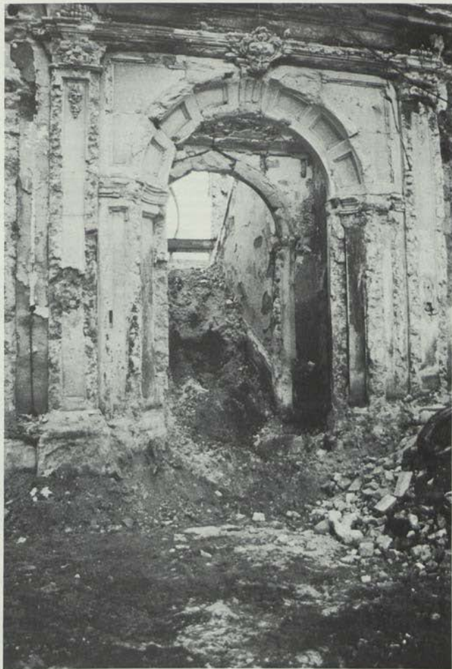
Armazéns do Chiado depois do incêndio Corpo Central: pormenor da decoração do Palácio
