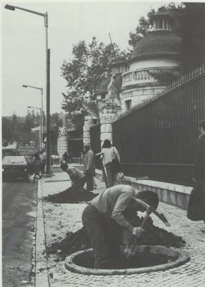
Aspecto dos trabalhos preparatórios para a plantação de novas árvores na cidade
