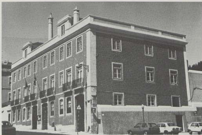
Actual sede da Junta de Freguesia de St.ª Isabel, na Rua Saraiva de Carvalho, n.º 8
