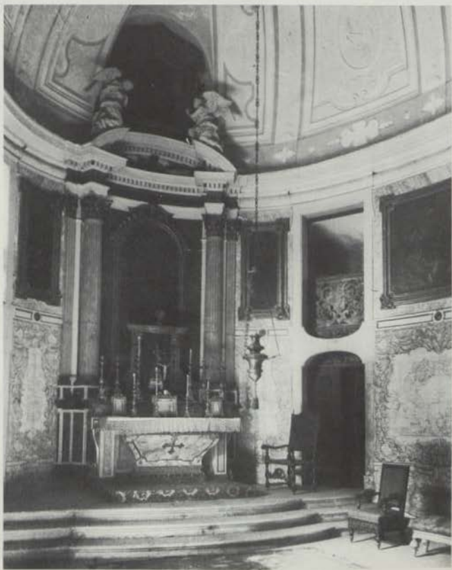
Aspecto do interior da destruída capela do Palácio da Mitra. Fotografia de José Bάρcia, de 1908
