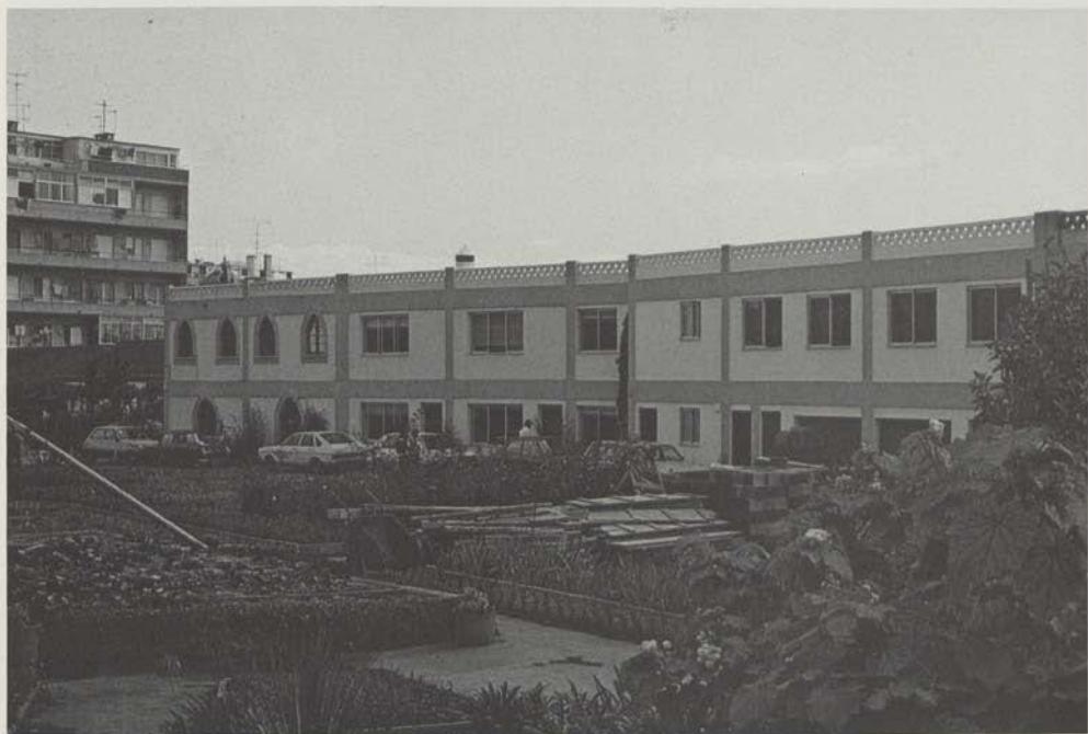
Instalações da futura Escola de Jardinagem, é sedida no Viveiro Municipal da Vila Correia, em Belém
