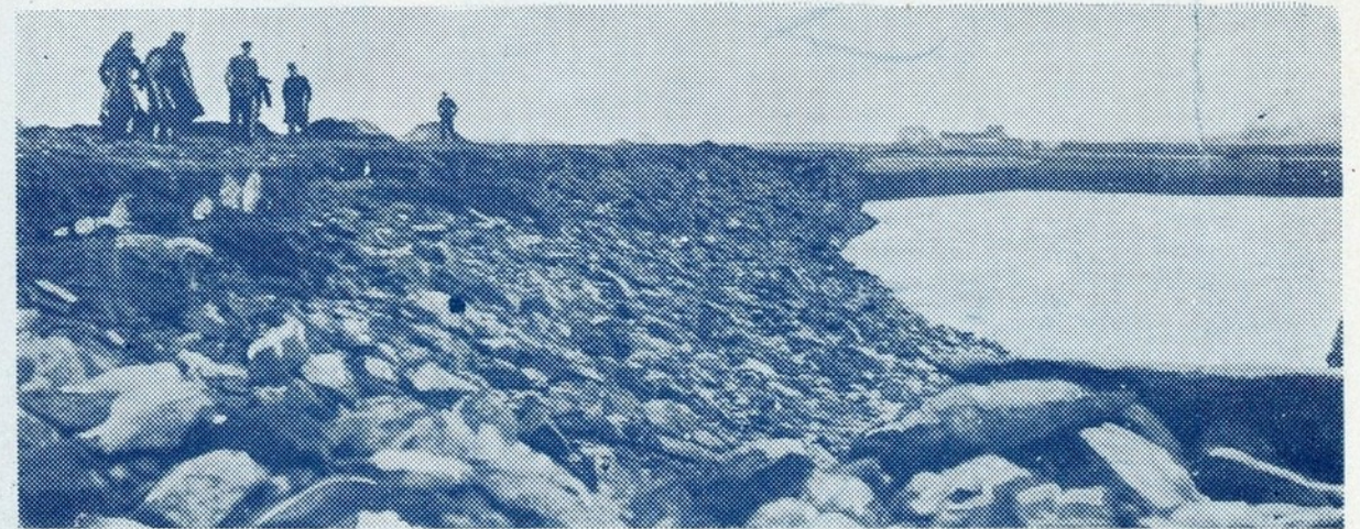
O estado deplorável em que ficou o cais do Bugio, em Viana do Castelo, após o ciclone
