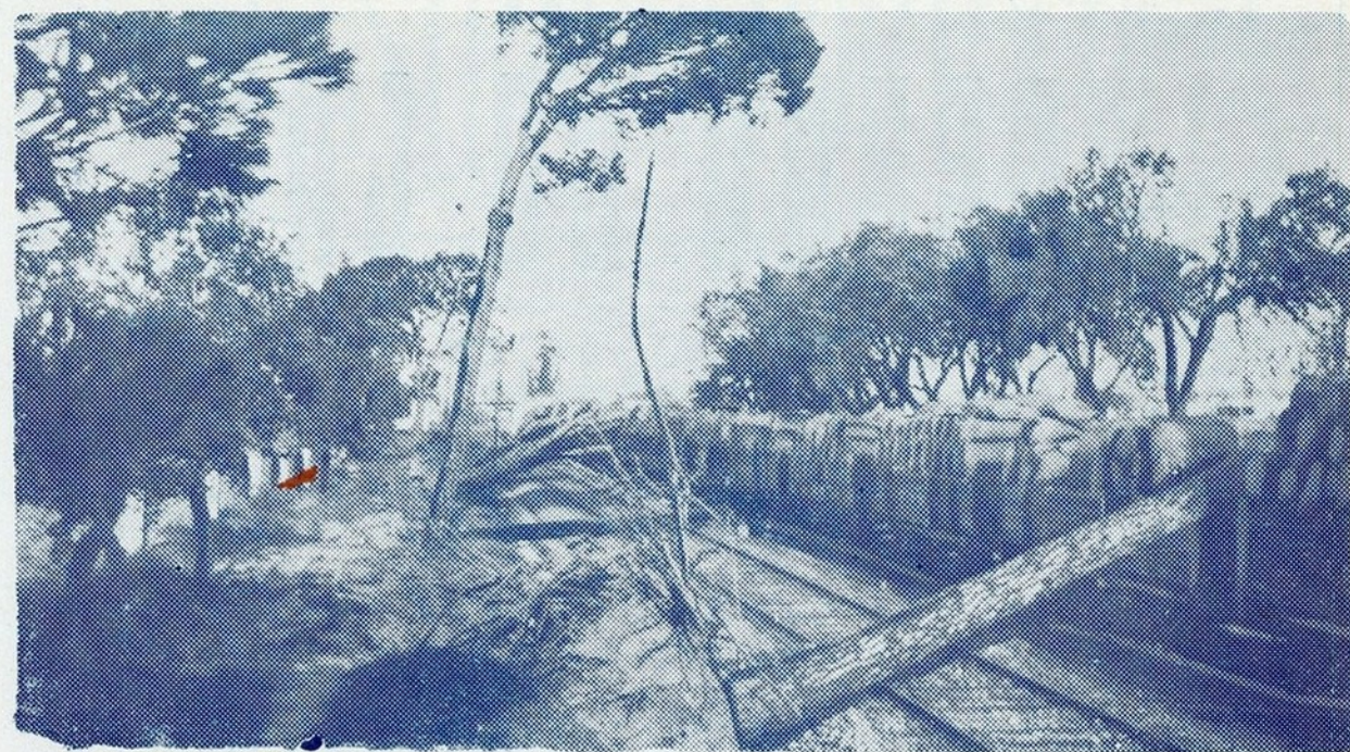
Eucaliptos gigantes derrubados sobre a linha ferrea, junto da Casa de Bragança, em Vendas Novas
