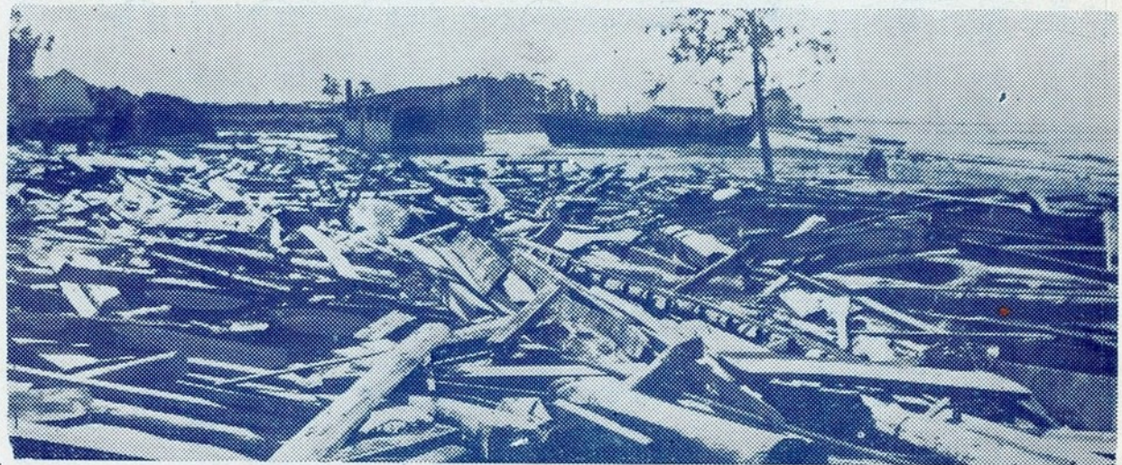
Montes de destroços a que ficaram reduzidos os estaleiros de Alcochete
